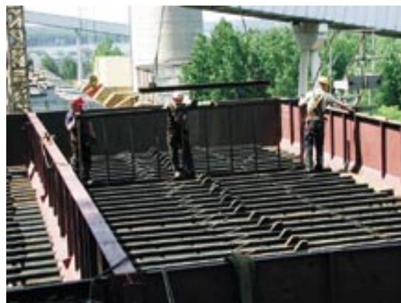
Montaż elektrofiltru kotła k-6
