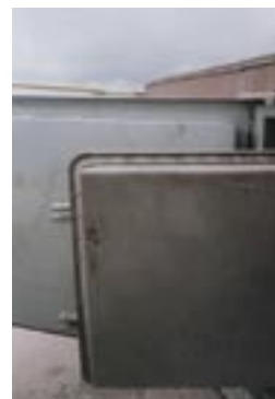
Zdj. nr 1. Pokrywa włącznika prawidłowo zamknięta - brak śladów korozji
