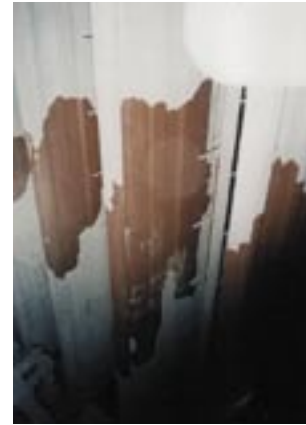
Zdj. nr 4. Usunięcie warstwy pyłu po jej nawilżeniu
